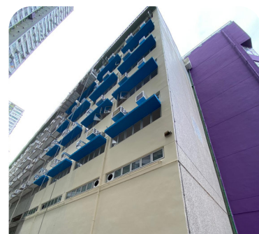
課室空調及抽風機安裝已完成
