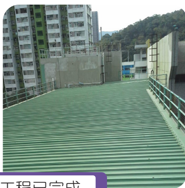
禮堂天台防水層修補工程已完成
